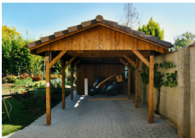
Carport avec réduit
