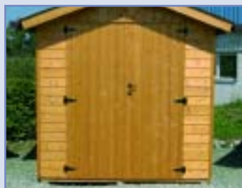
Porte à deux vantaux non vitrée avec serrure à mortaise
