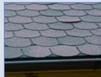
Ardoises bitumineuses arrondies, brunes
