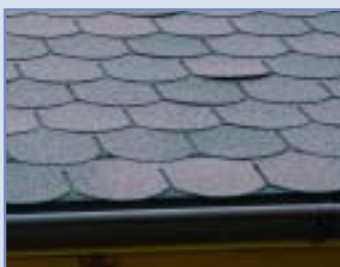
Ardoises bitumineuses arrondies, brunes
